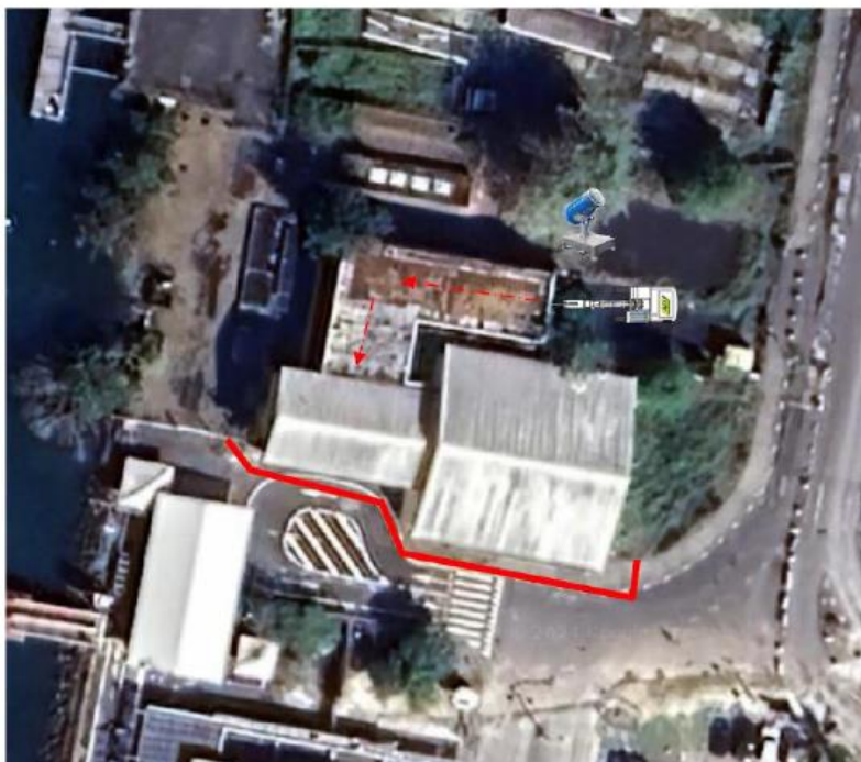
DEMOLITION DU BATIMENT BUREAUX
